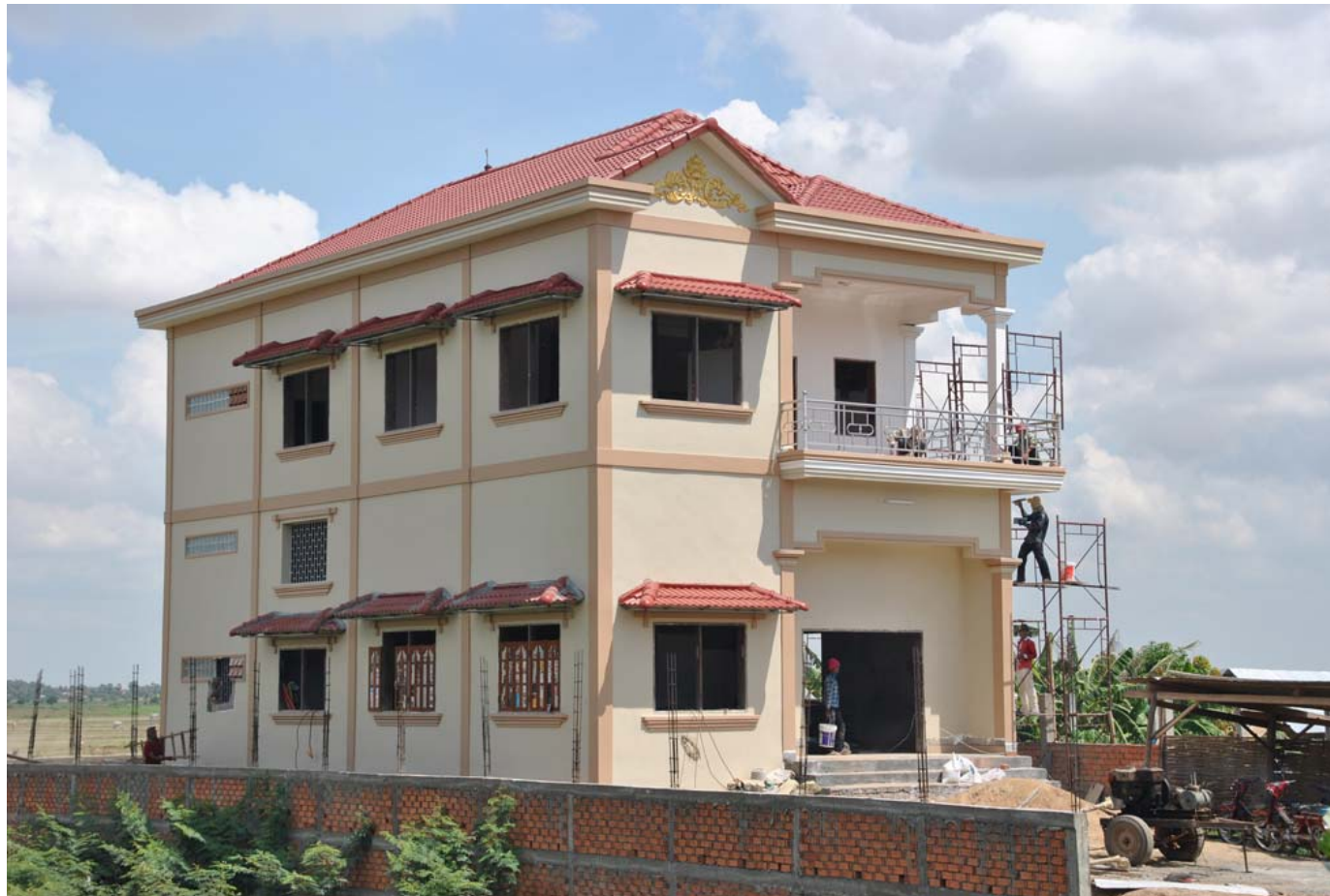
Außenansicht der neuen Englischschule
