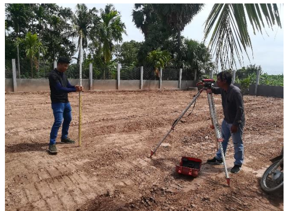
Das Grundstück auf dem die Schule errichtet werden soll, wird vermessen
